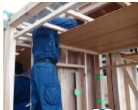
天井施工実習
