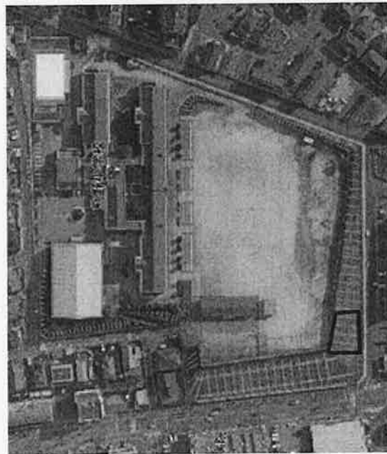
①工事場所
