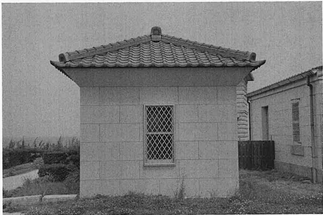
角島灯台旧倉庫外観
