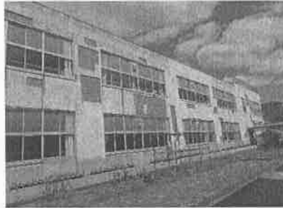
【外壁落下防止処置後】
