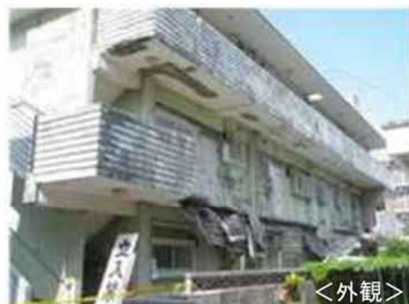
2階の廊下部分が崩落した事例
