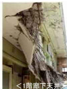
2階の廊下部分が崩落した事例
