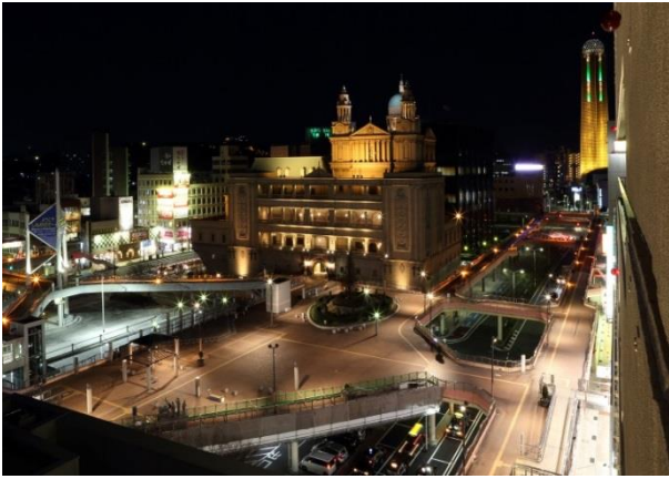
下関駅前人工地盤
