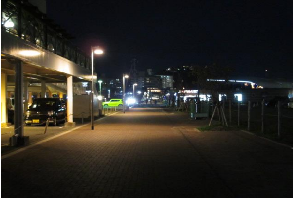
あるかぼーと広場前の歩道（整備前）
