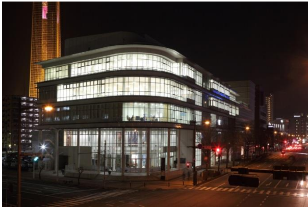
建物のファサードの演出例（下関市生涯学習プラザ）
