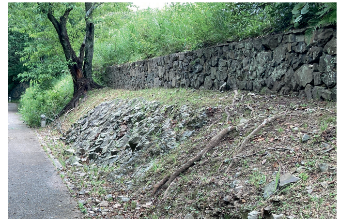
⑤ そのまま / 砲壘 岩盤を削った斜面や石積みなどかつての堡壘はそのまま保存
