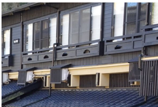
▲ 窓の欄干に模様をつけている。パイプ類も含め、壁面と同じ黒色で塗装
