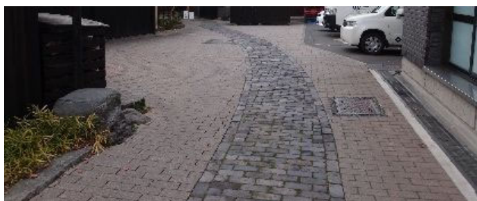
▲舗装をインターロッキングにすることで広場に
