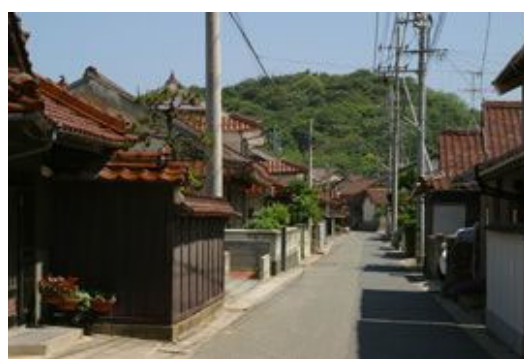
▲地元素材を活用した瓦屋根
