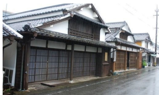
▲ 白壁・格子・庇で揃った建物
