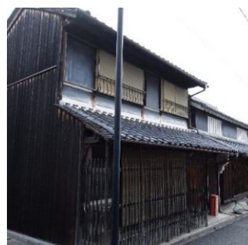
▲屋根の向き・勾配を揃えている
