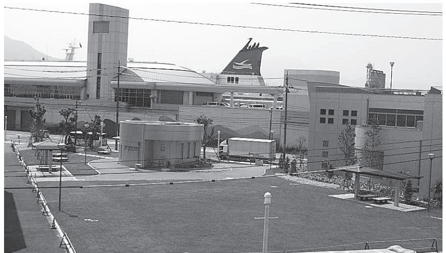
竹崎中継ポンプ場
