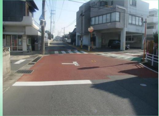
信号がなく、車両通行量、横断歩行者が多い交差点において、交差点位置を強調して示すことにより、ドライバーに横断者への注意及び速度の低減を促す手法。
