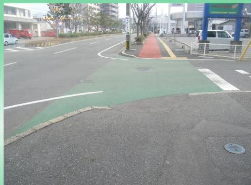
横断歩道の設置されていない車道横断箇所、歩行者の横断位置をカラー化することでドライバーに歩行者への注意喚起を促す手法。
