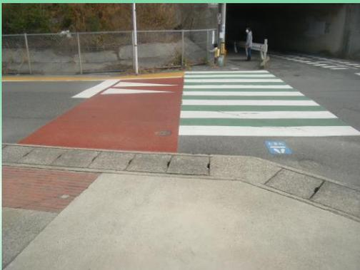
車両通行量、横断歩行者が多い横断歩道において、横断歩道位置を強調して示すことにより、ドライバーに横断者への注意及び速度の低減を促す手法。
