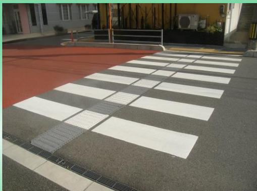
歩道に設置されている視覚障害者用誘導ブロック（点字ブロック）と同様に横断歩道上に突起体の列を設置し、視覚障害者の安全な横断歩道の利用を図る手法。
