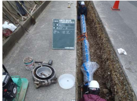
配水管布設替えの様子
