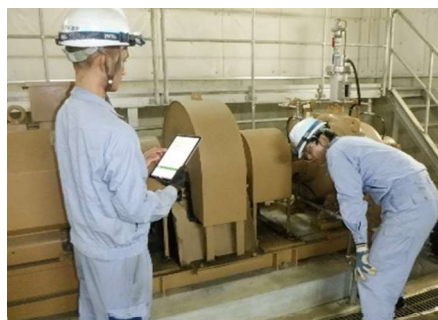
水道 設備台帳端末を使用した点検
