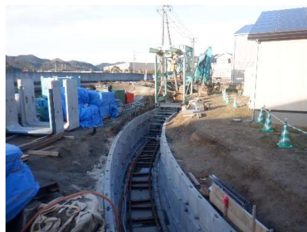
雨水渠の整備
