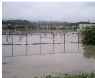
菊川浄水場 冠水
