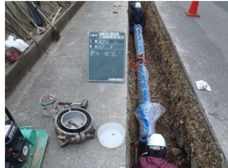
配水管布設替えの様子
