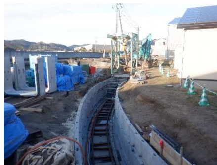
雨水渠の整備
