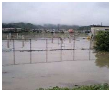
菊川浄水場 冠水
