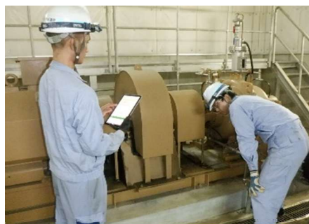
水道 設備台帳端末を使用した点検
