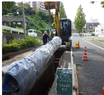
老朽管更新工事
