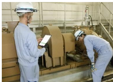
水道 設備台帳端末を使用した点検
