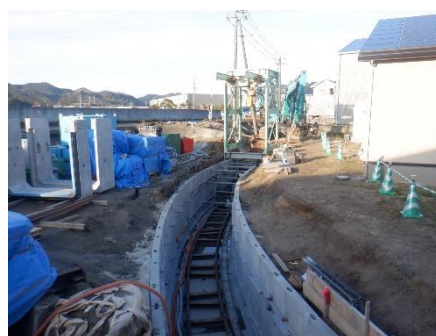
雨水渠の整備
