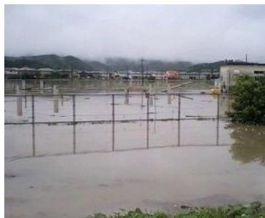
菊川浄水場 冠水
