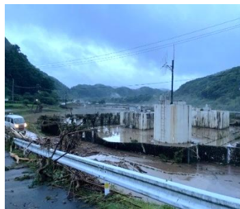
豊北町小河内水源地 濁水流入
