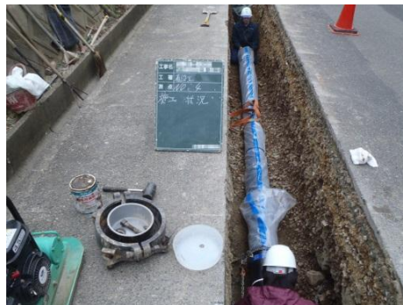
配水管布設替えの様子
