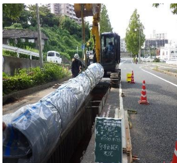
老朽管更新工事
