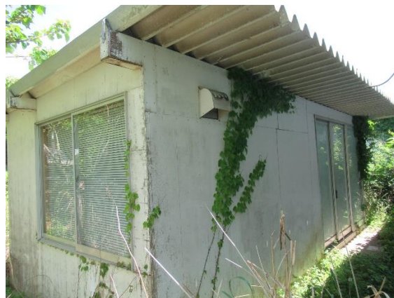
別棟倉庫 倉庫1
