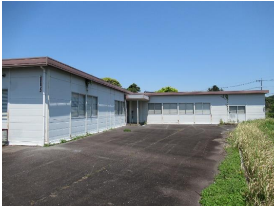
別棟倉庫 倉庫2
