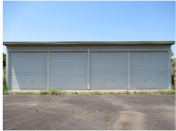
別棟倉庫 倉庫3
