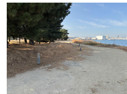
「既存照明設備」
