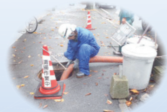
油で詰まった公共下水道管の清掃作業 公共下水道管が詰まると汚水が流れなくなりますので、大がかりな清掃作業が必要になります。
