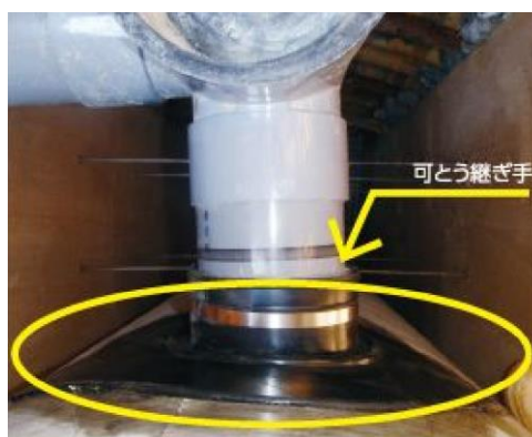
図 2.2.8 可とう継手(管渠とマンホールの継手)
