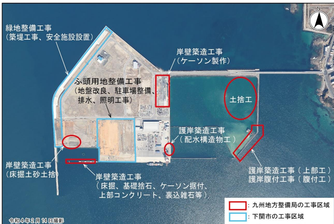
主な工事箇所（令和3年度）
