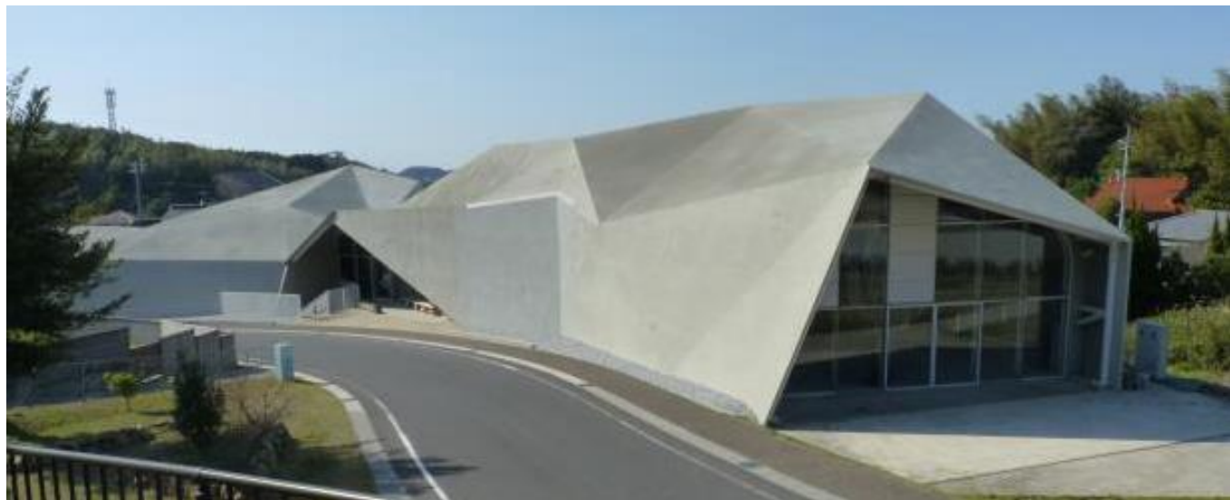
下関市川棚温泉交流センター（川棚の杜）
