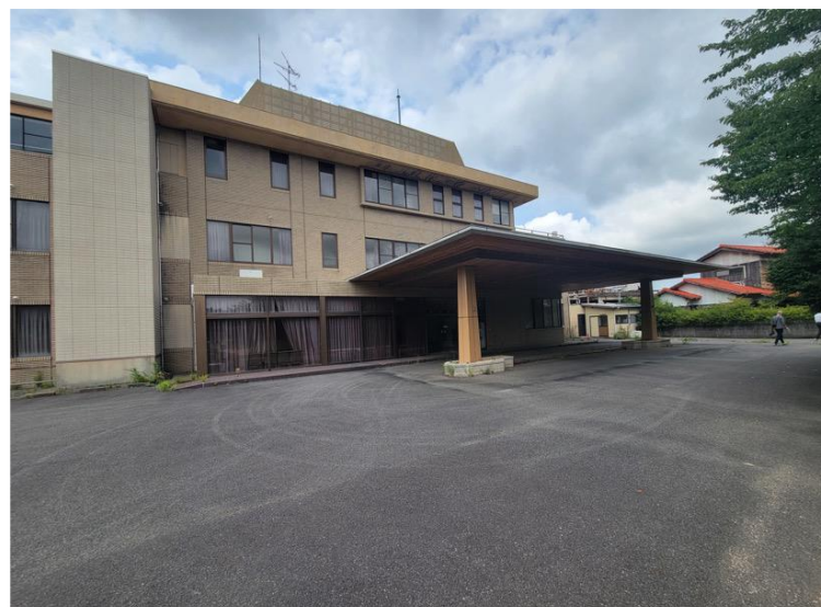
元温泉施設（旧滝部温泉・民間施設）
