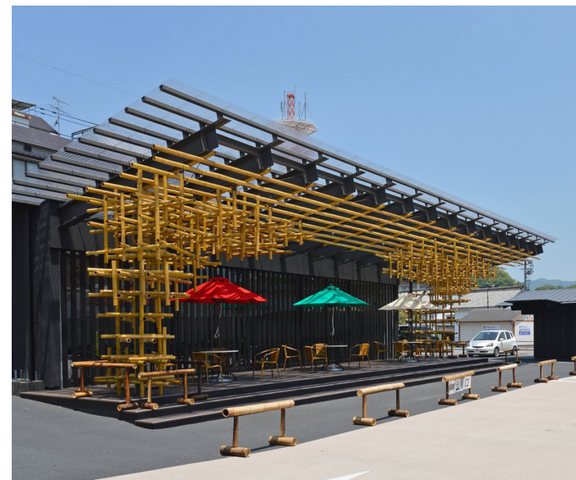
大分県 竹田市城下町交流プラザ (隈研吾建築都市設計事務所)
