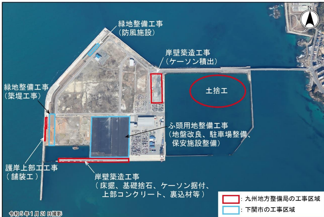
主な工事箇所（令和4年度）
